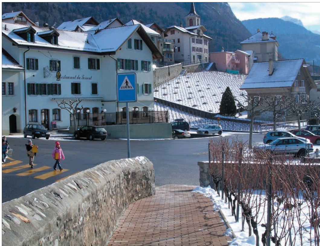
Fig34. Le débouché de la route de Corbeyrier sur la place du Torrent
