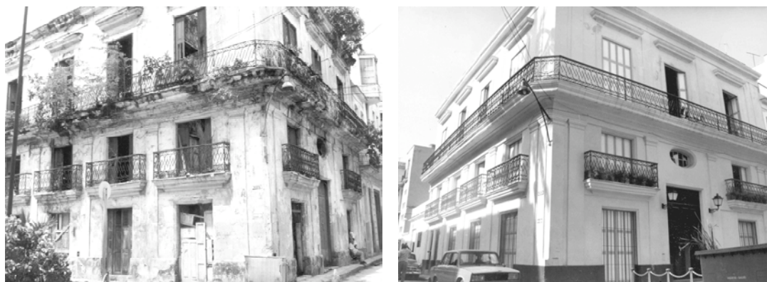
Fig. 51 : Exemple d'intervention achevée dans le quartier
