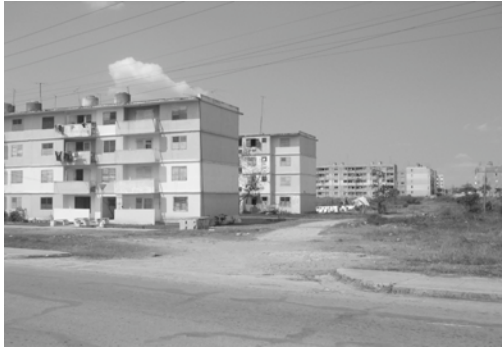
Fig. 10 : Exemples de bâtiments d'habitation construits dans les années septante situés à Santa Clara.
