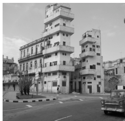
Fig.41 : Exemple d'édifice anciennement dédié à la prostitution
