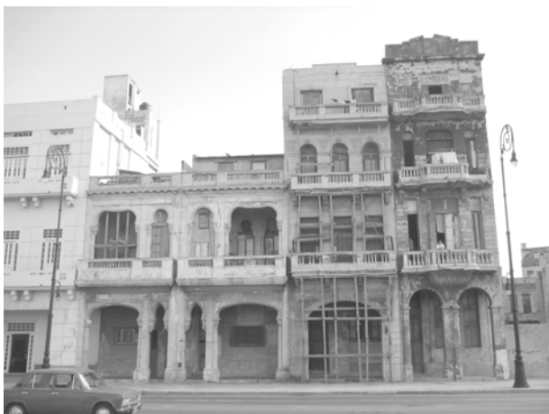
Fig. 78 : Les façades de l'îlot n° 7
