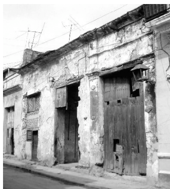
Fig. 52 : La façade de l'édifice situé à San Isidro 114
