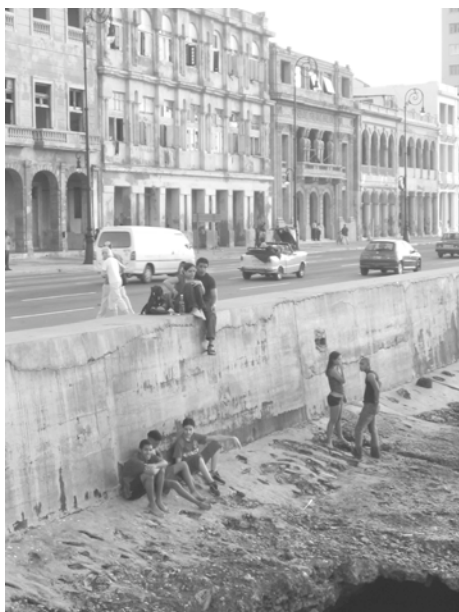
Fig. 85 : Le parapet du front de mer
