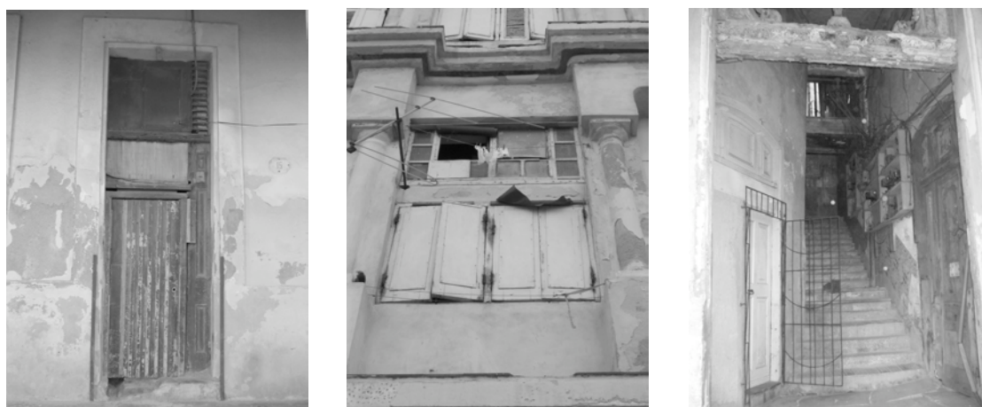
Fig. 83 : Exemples de logements précaires
