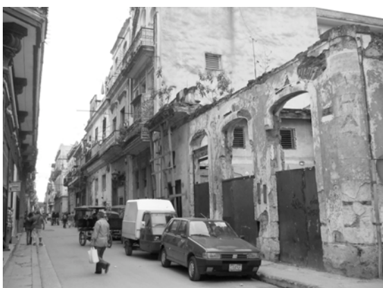
Fig. 21 : Un état de détérioration
