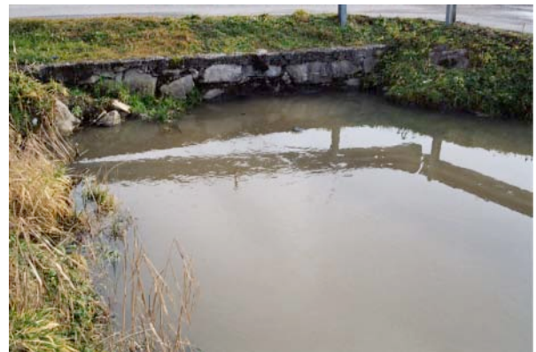
Photo 4.19 : canal du Bex. Le drain est sous l'eau.
