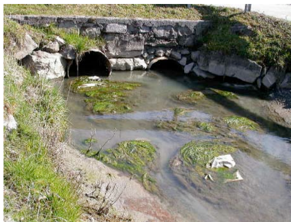
Photo 4.30 : canal du Bex
