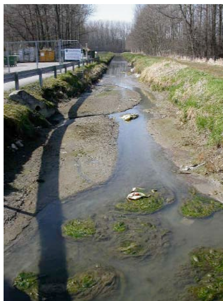
Photo 4.32 Canal du Bex
