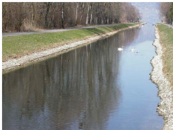
Photo 4.40 : dernier tronçon jusqu'au lac
