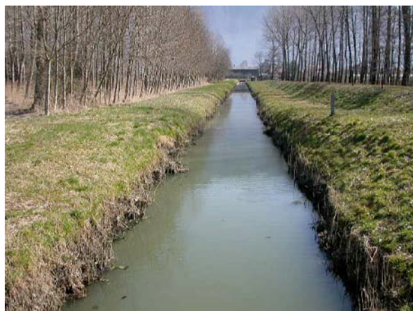
Photo 4.29 : canal du Bex
