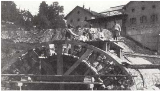
Canalisation du Flon et Entrepôt fédéral, vers 1890.
