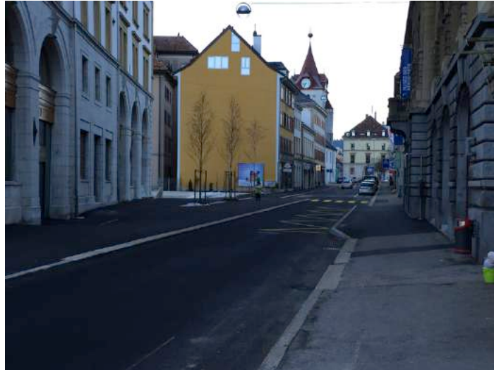
Figure 82 : Réaménagement de la chaussée devant l'Ancienne Poste. Source : Fabien Steiner
