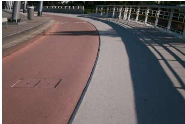
Figure 105 : Variation du revêtement du sol permettant de séparer l'espace. Source : pointdevueurlaville.org
