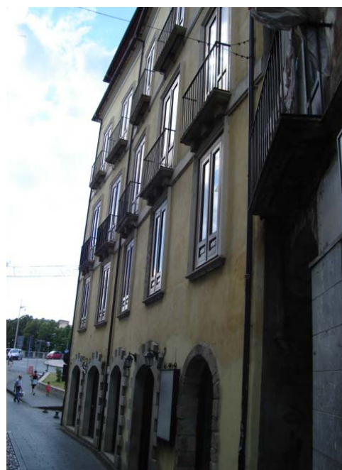
Photo 15 Façade ouest (SA, 2005)
