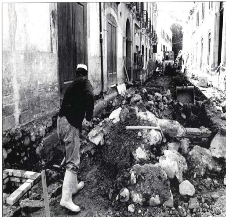
Photo 11 Travaux de requalification des sous services (Source : Aggarbati, idem : 38 )
