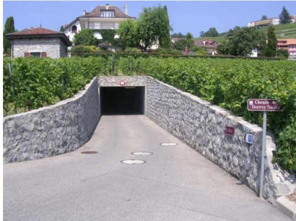
Photo 15 : le parking souterrain de Rivaz
