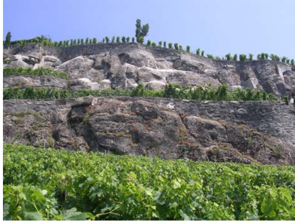
Photo 16 : bancs de conglomérats à l'état naturel (en bas) et consolidés artificiellement (en haut) à Rivaz
