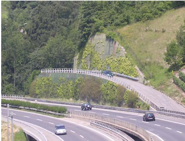
Photo 10 : mur de soutènement de l'autoroute A9 au-dessus d'Epesses
