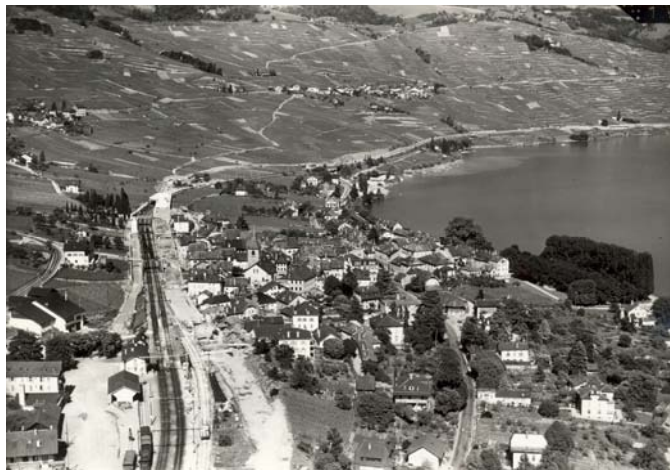
Photo 9 : construction de la route de contournement du bourg de Cully (1954)
