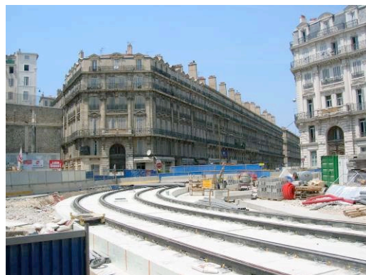
Figure 54 les travaux pour le futur tramway, Place Sadi-Carnot/Rue République
