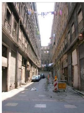
Figure 51 une cour intérieure
