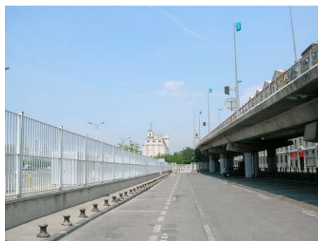
Figure 13 Les grilles du port, doublées par le viaduc
