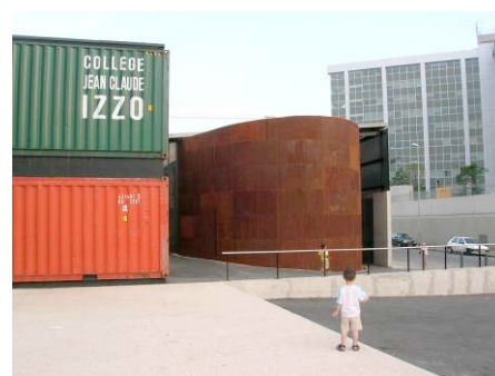
Fig. 63 Marseille, Joliette, un collège non loin du quartier des Docks, dont l'entrée faite de conteneurs reflète l'identité portuaire
