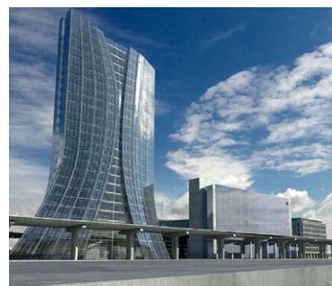
Ci-dessus, la tour de Zaha Hadid ; le chantier vient de démarrer (source : Euroméditerranée)
