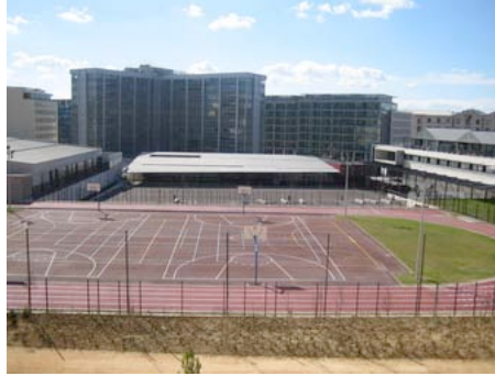
Figure 47 Vue en direction de la mer, nouveaux bureaux cachant les Docks, et stade d'athlétisme neuf accompagnant une nouvelle école, tout cela construit en un peu plus de trois ans sur un ancien terrain vague
