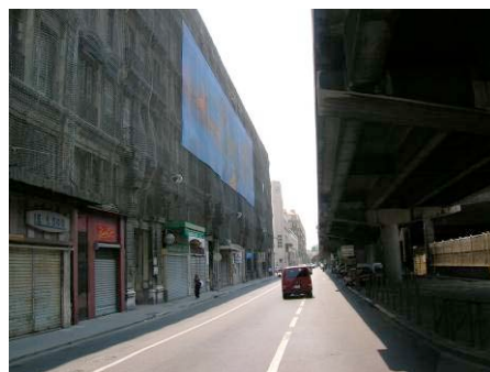
Figure 60 Quai de la Joliette ; à gauche l'édifice destiné à devenir l'immeuble de grand luxe de Marseille République, une fois le viaduc démoli
