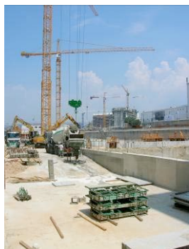
Figure 41 Le quartier des Docks encore en construction en 2006
