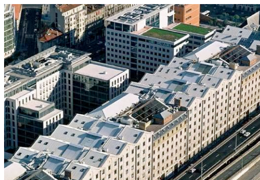
Figure 35 Le nouveau quartier d'affaires de la Joliette, alliant modernité architecturale et identité portuaire
