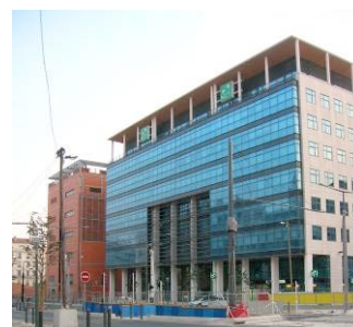
Figure 40 Cap Joliette, le bâtiment inauguré en 2004 par la société BNP Paribas, à côté du bâtiment rouge de Télécom Italia
