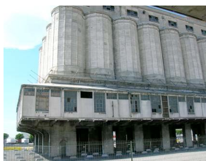
Figure 68 L'état actuel du Silo
