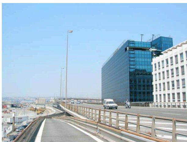
Figure 32 Le port, le viaduc autoroutier, les bureaux de la CMA-CGM (2 bâtiments)
