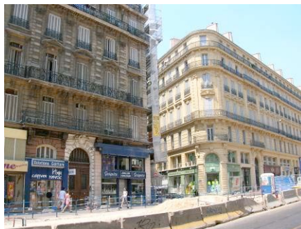
Figure 52 : contraste entre deux façades d'immeubles, celle du fond venant d'être réhabilitée
