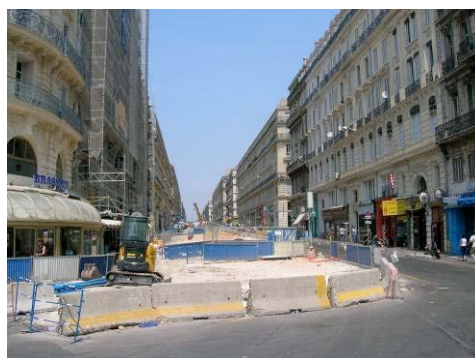
Figure 56 vue du linéaire de façade depuis le Vieux-Port (le tramway ne longera pas toute la rue de la République : il ira jusqu'à la place Sadi-Carnot puis opérera un virage sur la rue Colbert)
