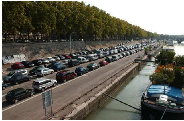
Fig. 10 - Dès les années 60, les quais deviennent des parkings (Site internet du Grand Lyon)
