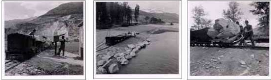
Fig. 4 - Extraction et transport de blocs pour la 2 ème correction (Plan sectoriel, 2005)
