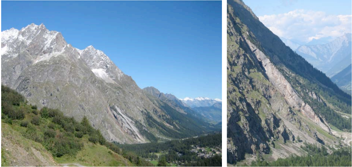
Photo 7 : La Dalle de l'Amône
