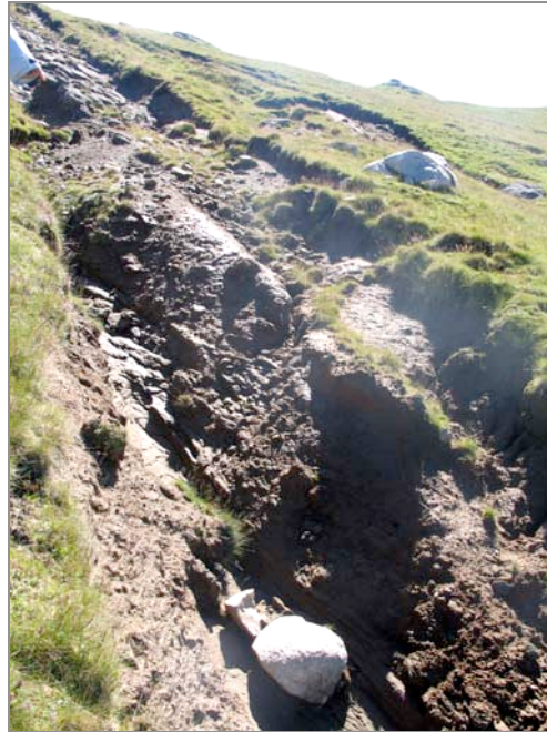
Figure 21 : Destructuration des sols par activité torrentielle le long d'un chemin pédestre sur le mont Furnica
