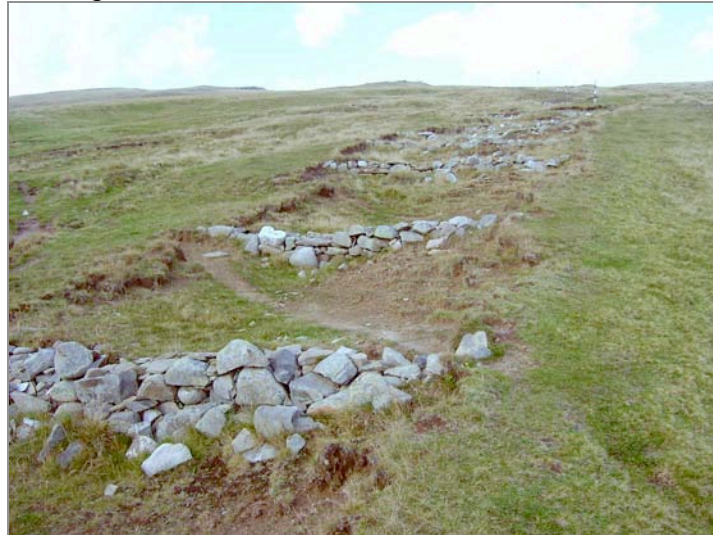
Figure 47 : Seuils en pierre au mont Furnica construits pour arrêter le développement des ravins de grandes dimensions.
