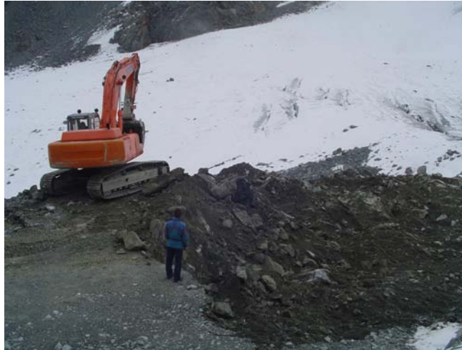
Figure 24 : Travaux d'abaissement de la route menant au glacier (octobre 2006)
