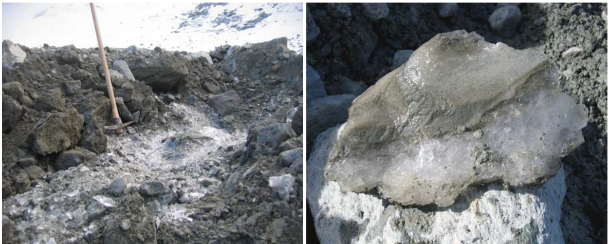
Figure 25 : Glace massive mise à jour lors des travaux d'abaissement de la route menant au glacier (Photos : C. Lambiel)
