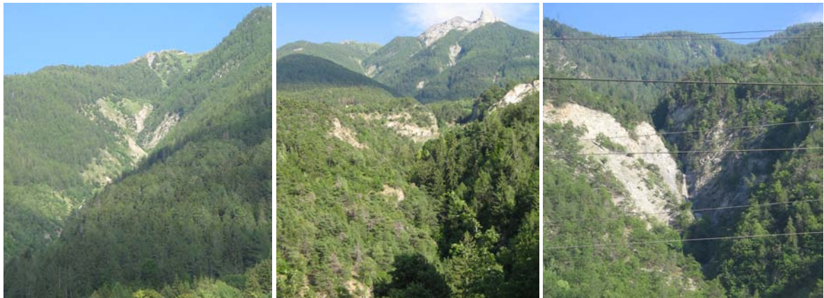
Photos 6-7-8 : Zones d'accumulation et chenal d'écoulement des Torrents du Saxonnet et d'Ecône.
