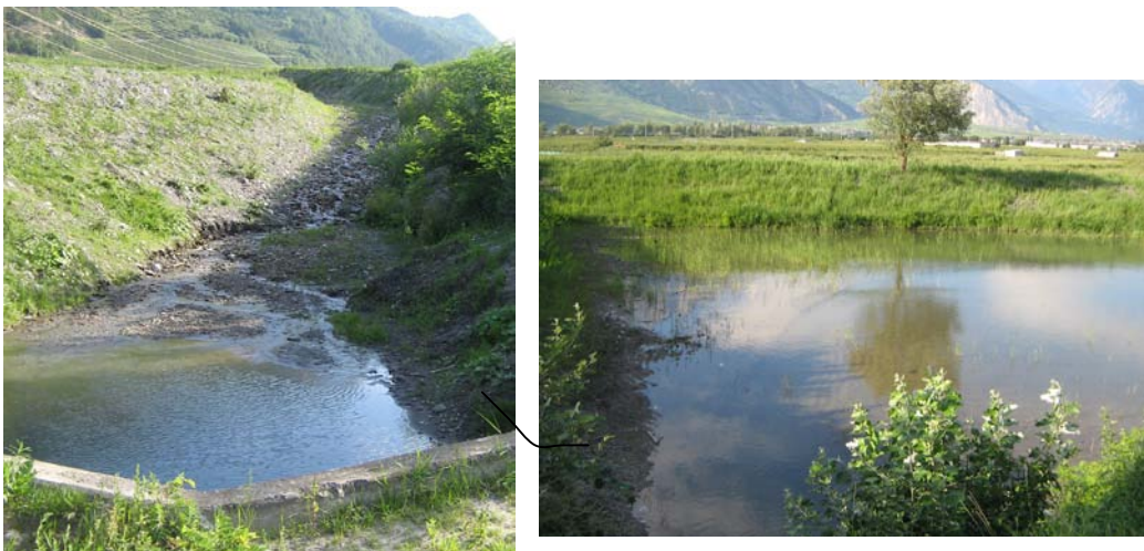
Photos 9-10 : Aval du Torrent d'Ecône et ouvrage de protection construit à l'arrière.
