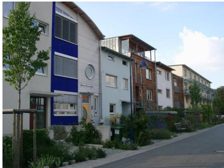
6.1-V – Groupe de bâtiments au quartier Vauban
