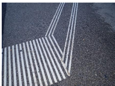
Figure 32 : Bande de guidage et carré podotactile d'arrêt de transport public (Source : Wegmann, 2016)
