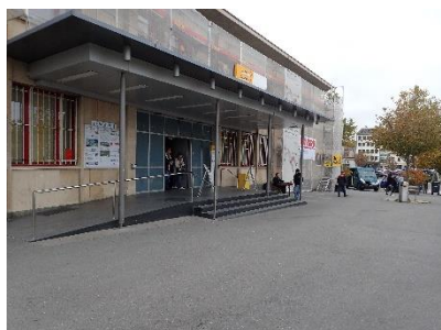
Figure 27 : Rampe d'accès au bureau de poste à la gare (Source : Wegmann, 2015)
