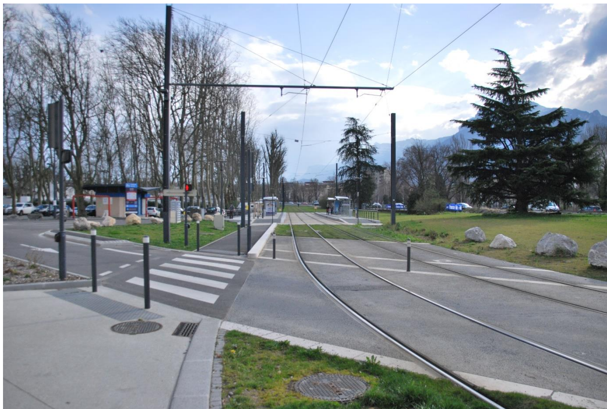
Figure 39 : traversée de route entièrement abaissée, équipée de bandes podotactiles. Exemple à Grenoble, dans le quartier de l'Esplanade (Source : Wegmann, 2015)
