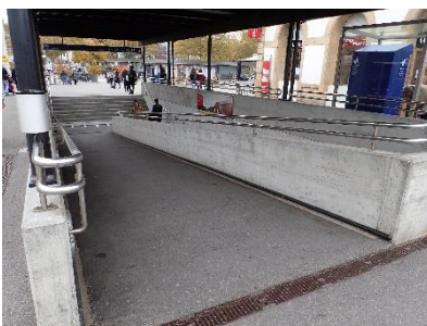
Figure 26 : Rampe d'accès au quai 2 à la gare d'Yverdon (Source : Wegmann, 2015)
