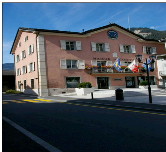
Photo 6.1. : Maison communale du Châble ( www.bagnes.ch ).
