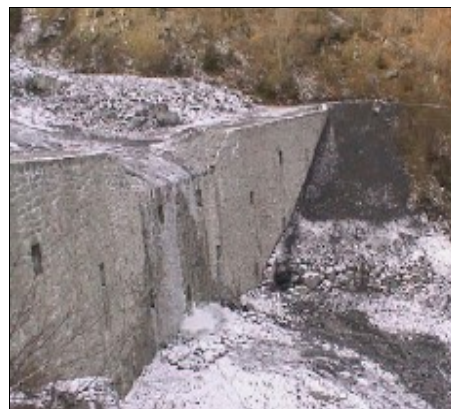
Fig. 6.6.3 : Détail d'un des barrages torrentiels du Saint-Barthélémy (tiré de www.esm-group.ch ).
