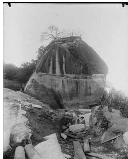
Fig. 6.1.9 : Travaux d'approche en vue de l'exploitation de la Pierre des Marmettes (Siebenmann, 1935).
