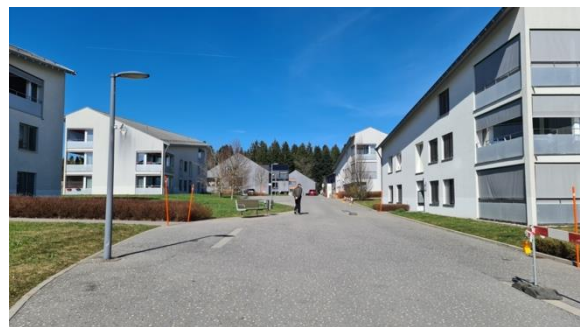
Figure 15: Allée entre les Maisons de Pra Roman. Source : Alberti, 2024
