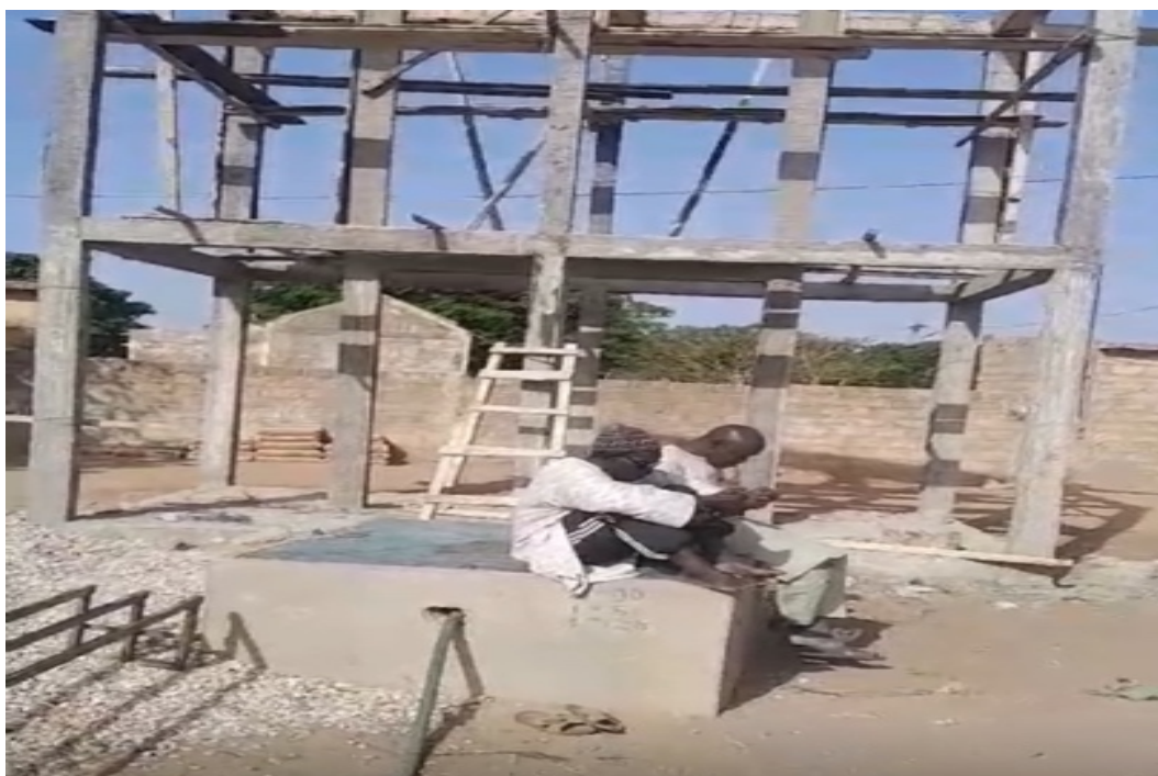
Figure 13 : Construction du château d'eau de Keur Madiagne par les populations locales
