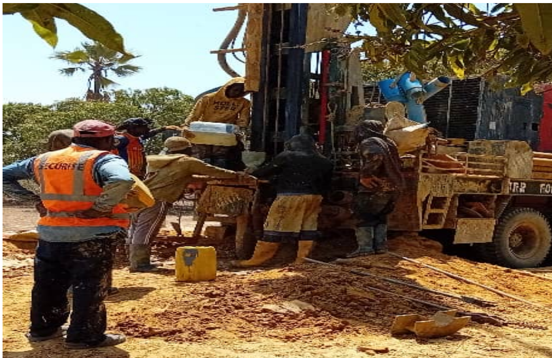
Figure 12 : Creusement d'un-forage dans la zone des cinq villages par la commune de Taïba Ndiaye
