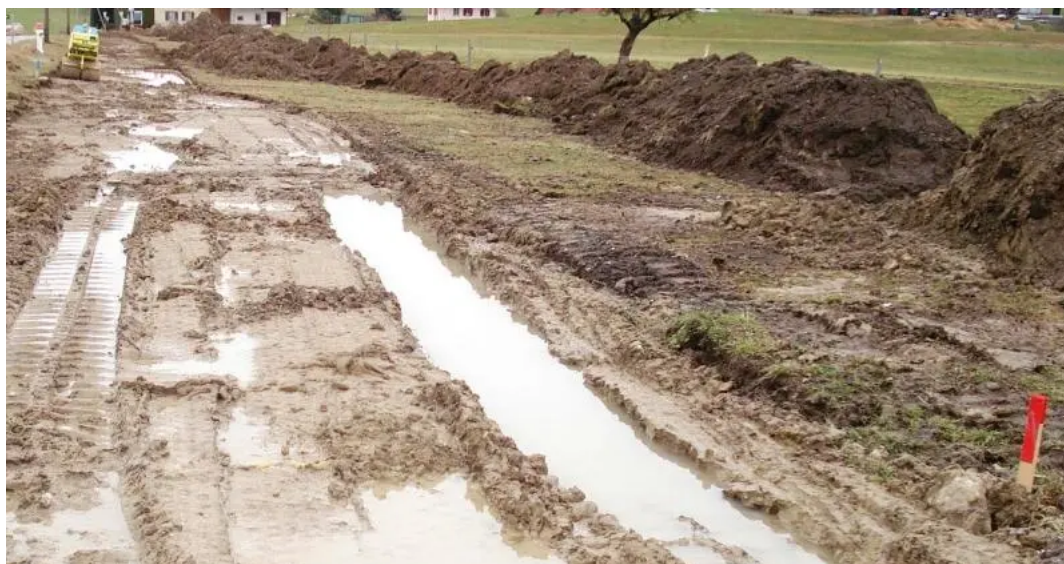
Figure 7 : Sol compacté (État de Fribourg, 2018).
