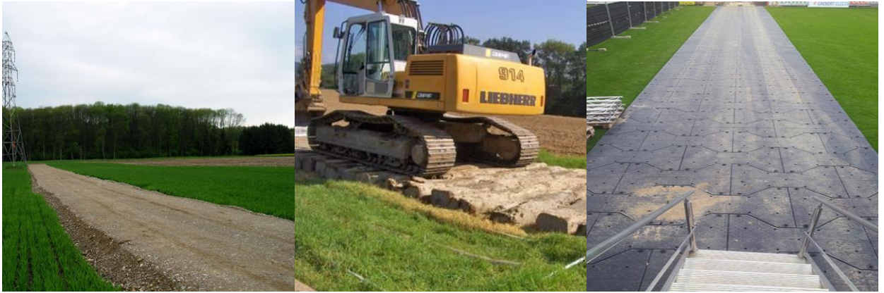
Figure 14 : Piste en grave, en rondin, et en plaques emboitables (Techni, 2018).
