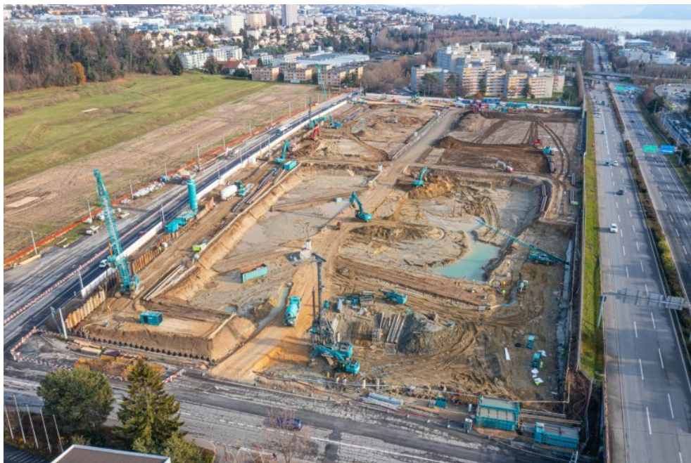
Figure 12 : Chantier du quartier Horizon, Chavannes-près-Renens (Orllati, 2023).
