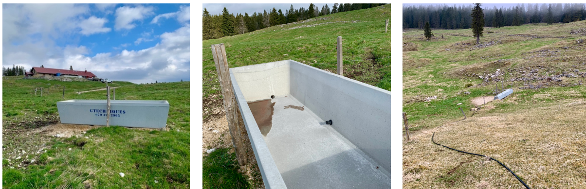
Figure 11. Systèmes de distribution d'eau en alpage. Les images de gauche montrent des bassins utilisés pour distribuer l'eau au bétail, et à droite, un tuyau qui achemine l'eau par gravité depuis la citerne enterrée jusqu'au bassin pour le bétail (Photos : Lorena Roulin).
