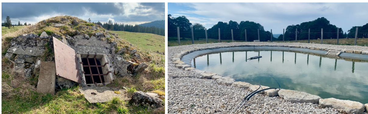
Figure 10. Systèmes de stockage d'eau en alpage. À gauche, une citerne enterrée utilisée pour le stockage de l'eau ; à droite, un étang servant de réservoir agricole (Photos : Lorena Roulin).
