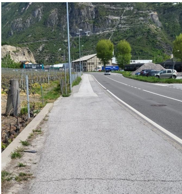
Figure 32 : Arrivée dans le tronçon, absence notable de bandes cyclables
