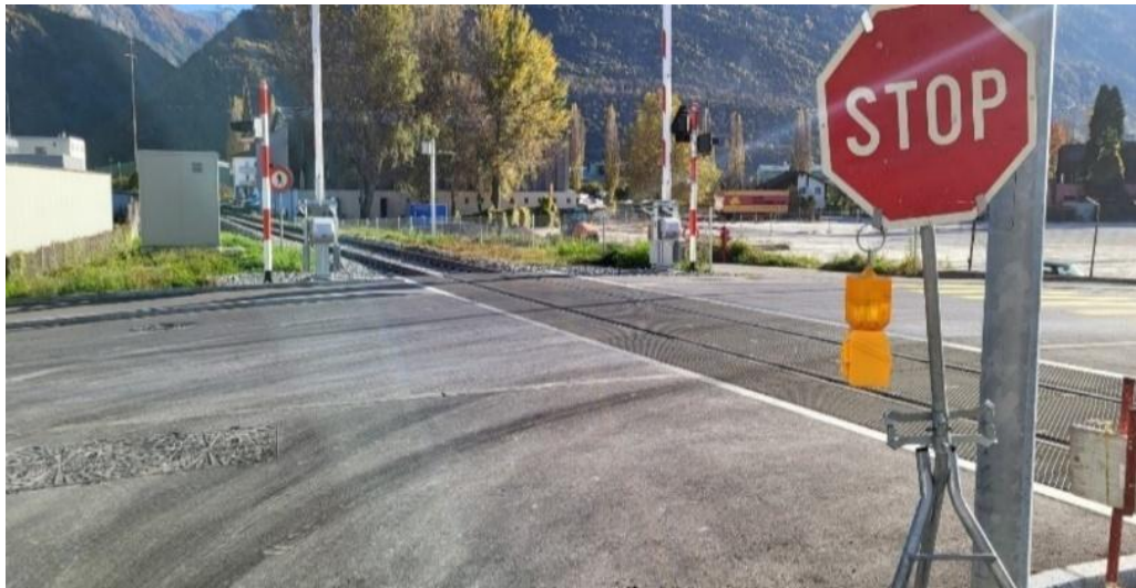
Figure 24 : Passage à niveau à la jonction des tronçons Platanes - les Halles
