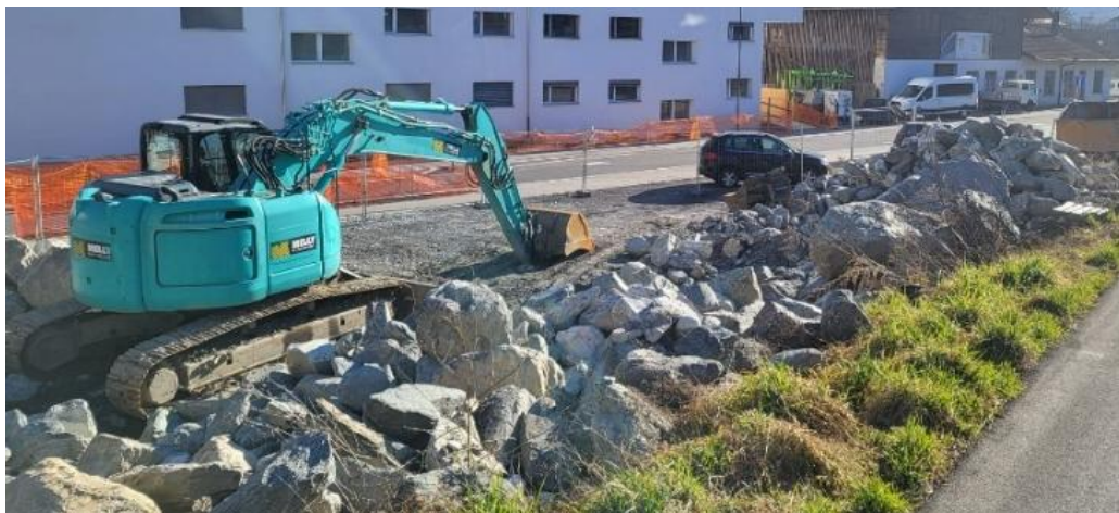
Figure 18 : Travaux présents aux bords du tronçon
