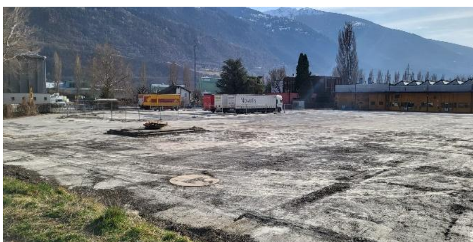
Figure 31 : Place goudronnée à l'entrée du tronçon
