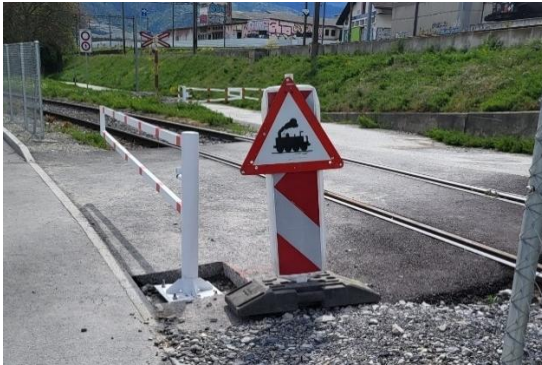
Figure 19 : Chemin menant à un domaine sportif qui nécessite de traverser des voies ferrées
