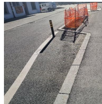
Figure 15 : Exemple de structure induisant un rétrécissement de la chaussée
