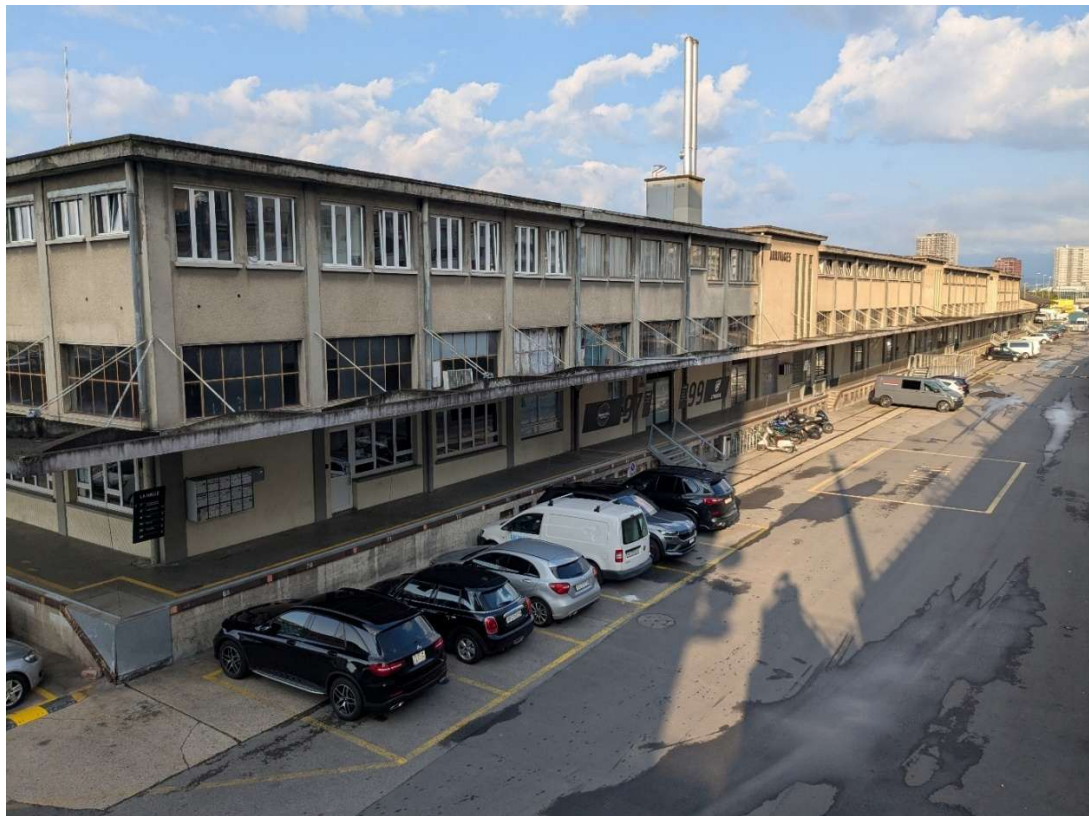
Figure 47: Vue de la façade nord de la halle historique, qui accueille les différentes activités transitoires. Source: Nicolas Käppeli, 2025.
