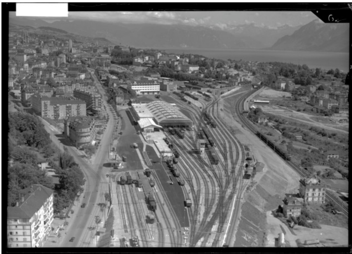
Figure 42: le plateau de Sébeillon avec la gare nouvellement construite, en 1953. On remarque que le secteur était alors presque entièrement occupé par les faisceaux ferroviaires. Source : Photo Aéroport Lausanne, 1953, Musée Historique Lausanne
