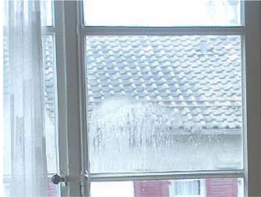
Figure 10 Condensation à l'intérieur du double vitrage
