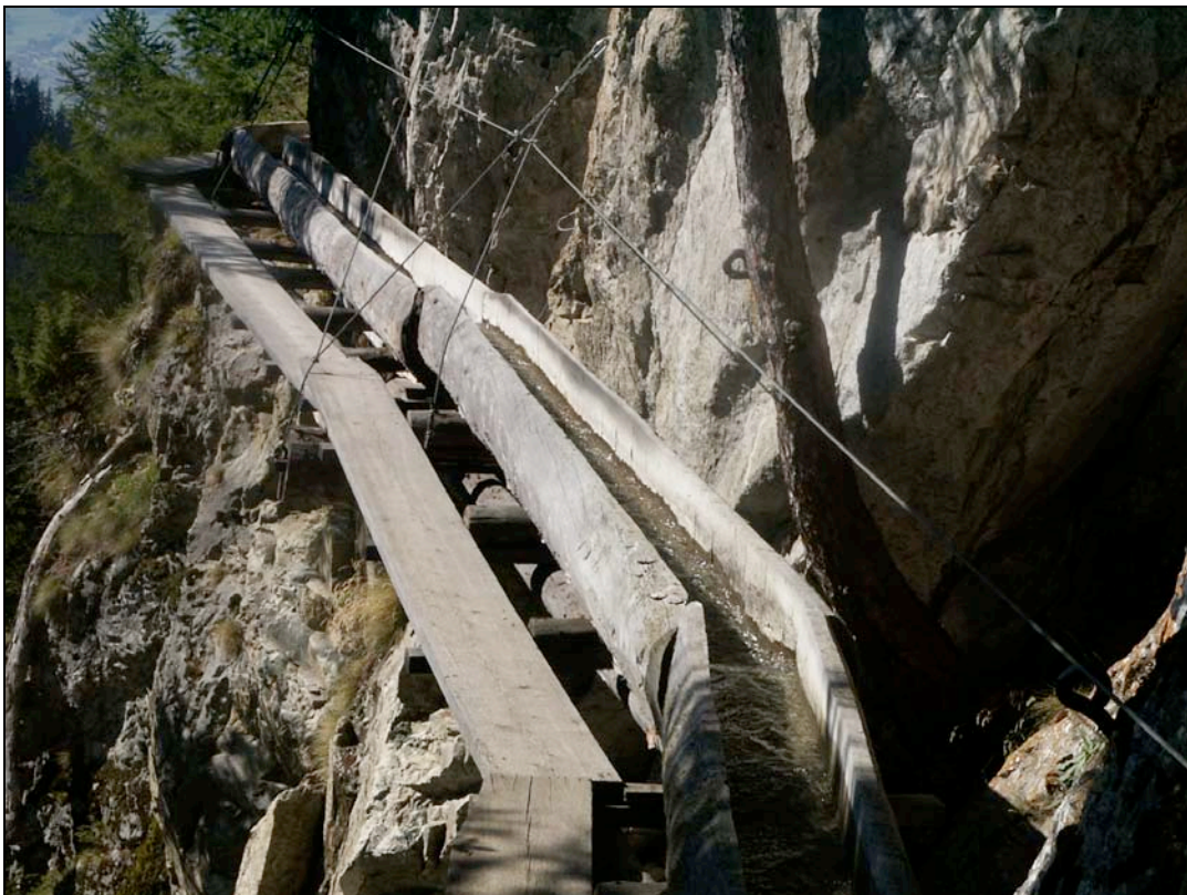
Fig. 6 – Secteur en bois (tronc évidé, typique des bisses du Haut-Valais) sur le Ladu Suon dans le Jolital.
