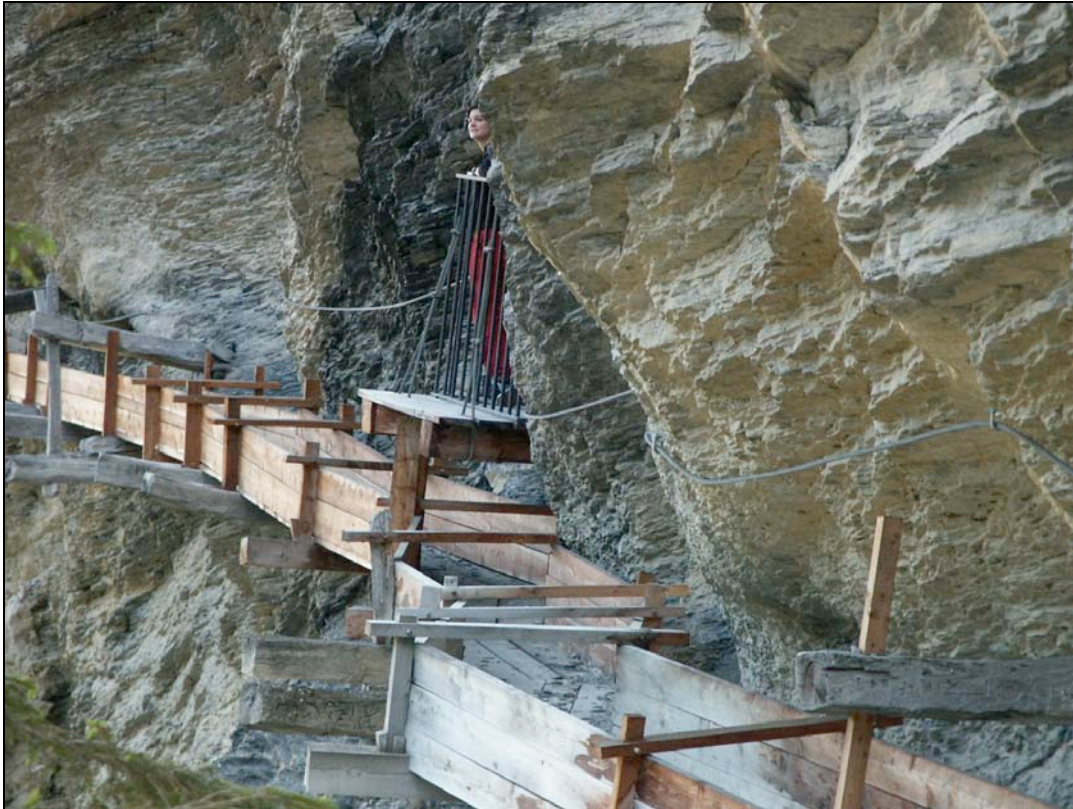
Fig. 5 – Secteur en bois au bisse d’Ayent pour le passage d’une paroi calcaire. Ce secteur a été remplacé par une galerie (voir ouverture avec balcon au centre de la photo) en 1831 et reconstruit pour des raisons touristiques dès 1991.
