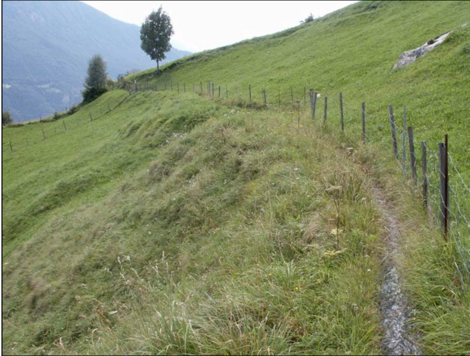
Fig. 3 – Un bisse creusé directement dans le terrain près du village de Mund.
