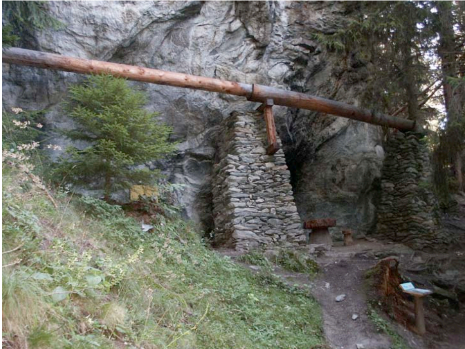
Fig. 4 Restauration de vestiges suspendus au Riederi (Ried-Mörel)
