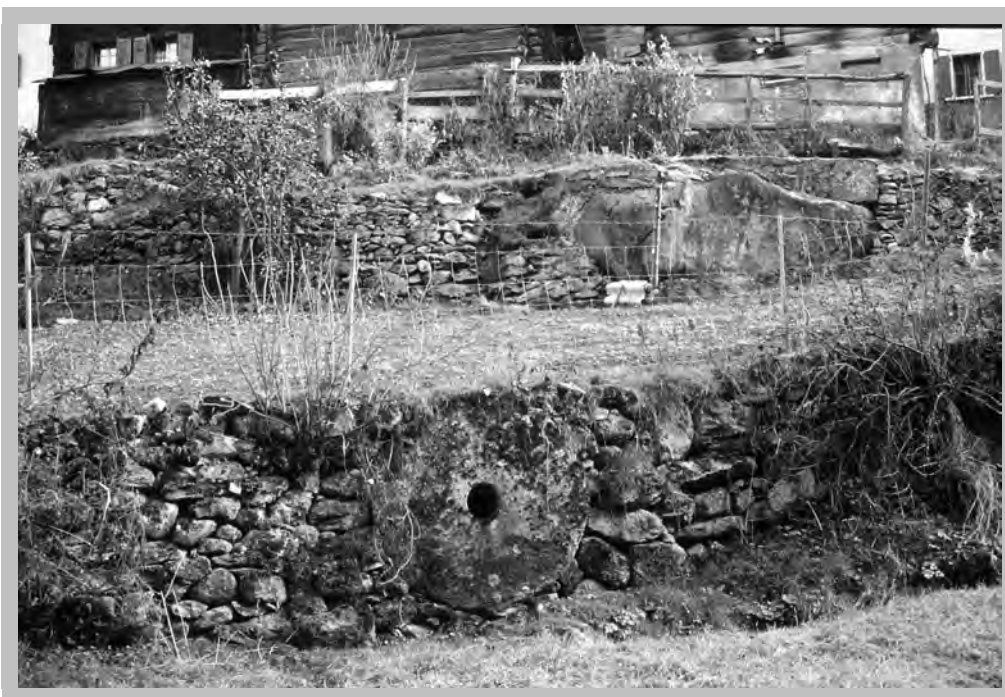
Planche X Vestiges de meule de moulin utilisée pour la construction d'un mur dans le village de Beuson (Photo : E. Reynard, 1995)
