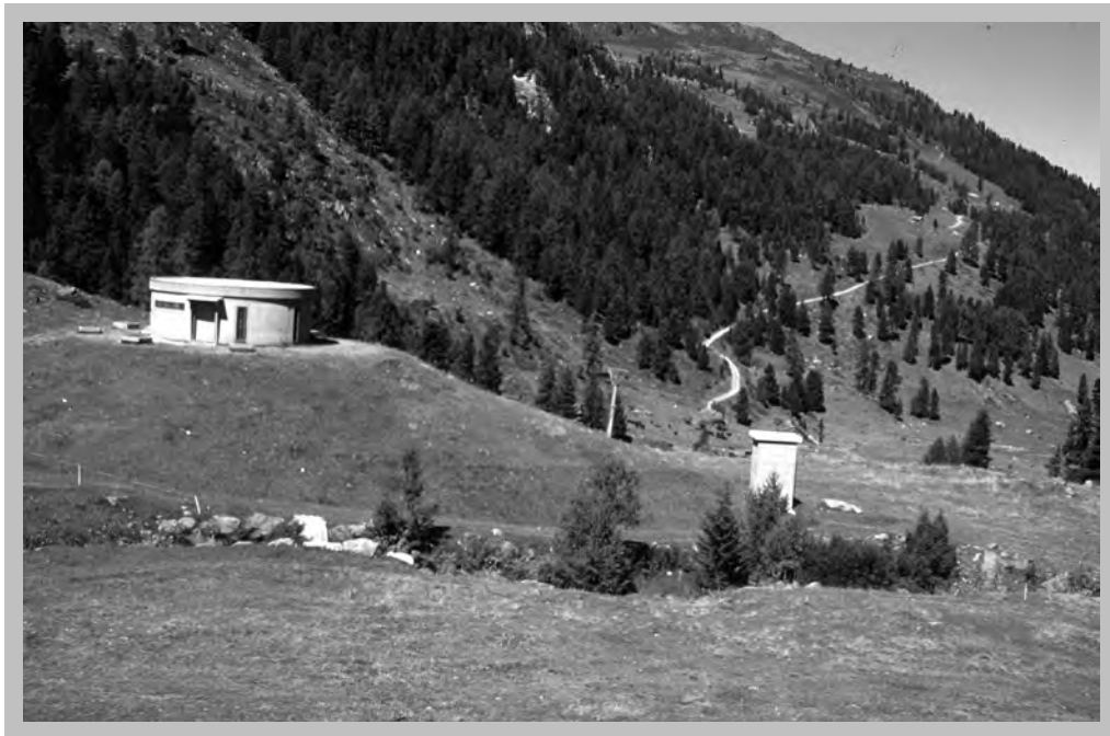
Planche VII Station de traitement des eaux de la commune de Nendaz à Pra Mounet (Siviez) (Photo : E. Reynard, 1997)
