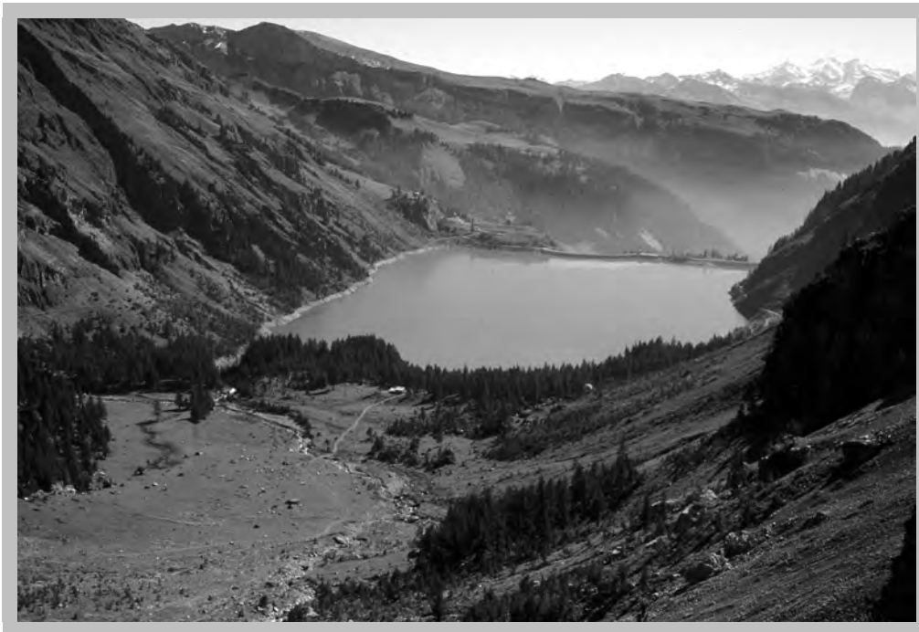
Planche XI Barrage de Tseuzier (vu depuis le karst du Ténéhet) (Photo : E. Reynard, 1998)
