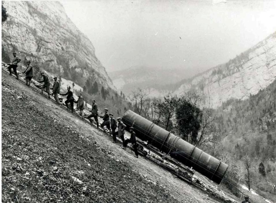
Fig. 1 *A la fin de la guerre de 1914 - 18, des ouvriers de la SDEM (Société d'Etudes et de Montage), filiale de Bouchayer & Viallet, ainsi que des prisonniers allemands transportent une conduite forcée à Rencurel, Isère, pour la Société Hydroélectrique de la Bourne. Collection Musée Dauphinois*
