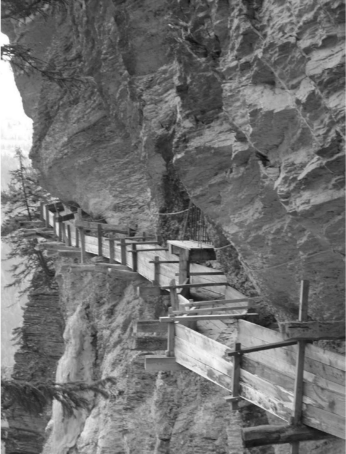
*Photo 5 Détails des rénovations des vestiges du bisse à Torrent-Croix. Les travaux ont été réalisés et financés par le consortage.*
