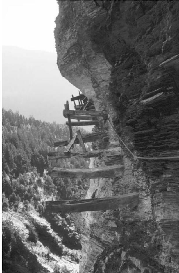
*Photo 2 Vestiges (boutsets) du bisse d'Ayent à Torrent-Croix. Sur ce secteur, le canal, autrefois suspendu contre la paroi, a été remplacé par un tunnel creusé en 1831. Ces vestiges ont été restaurés en 1991 et 1997 (voir photo 3).*
